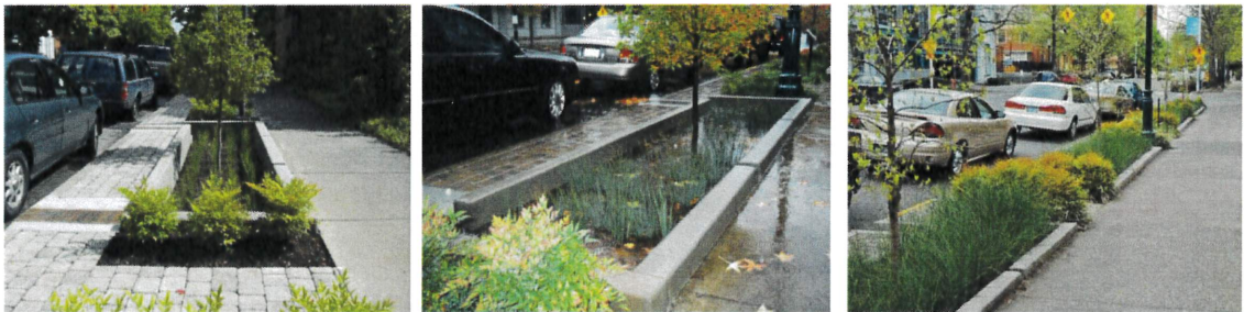
Figure 38. Mesures de gestion des eaux pluviales
