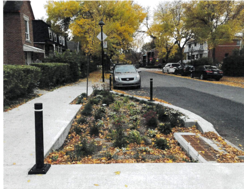
FIGURE 5 - Saillie de rue destinée au drainage
