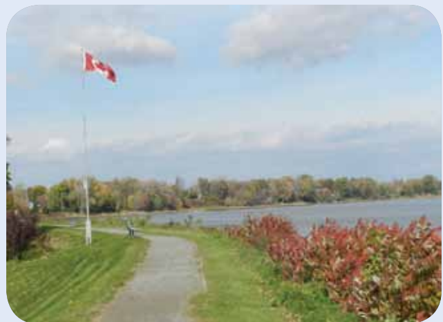
Secteur Grand-Moulin muni d'une digue végétalisée en 2017.
